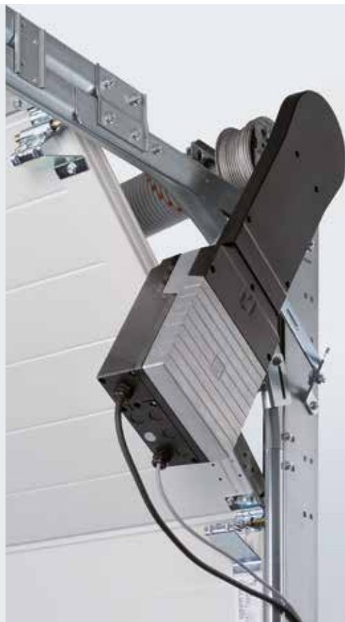
Diagonalny wariant montażowy
